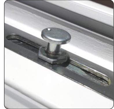
Pilzkopfbolzen aus einsatzgehärtetem Stahl
